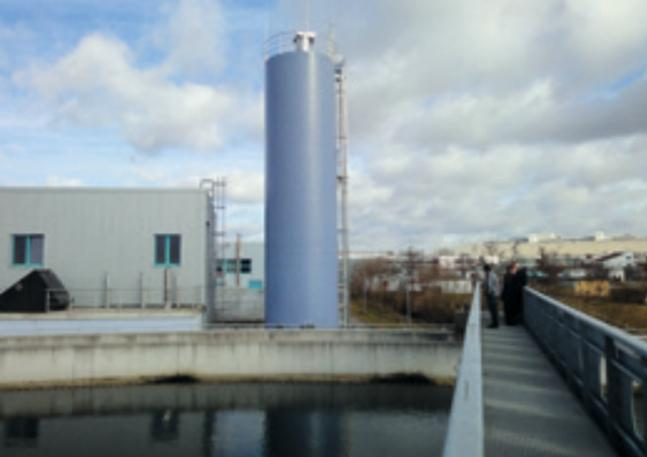
Kläranlage Böblingen-Sindelfingen, Adsorptionsstufe mit Pulveraktivkohle
