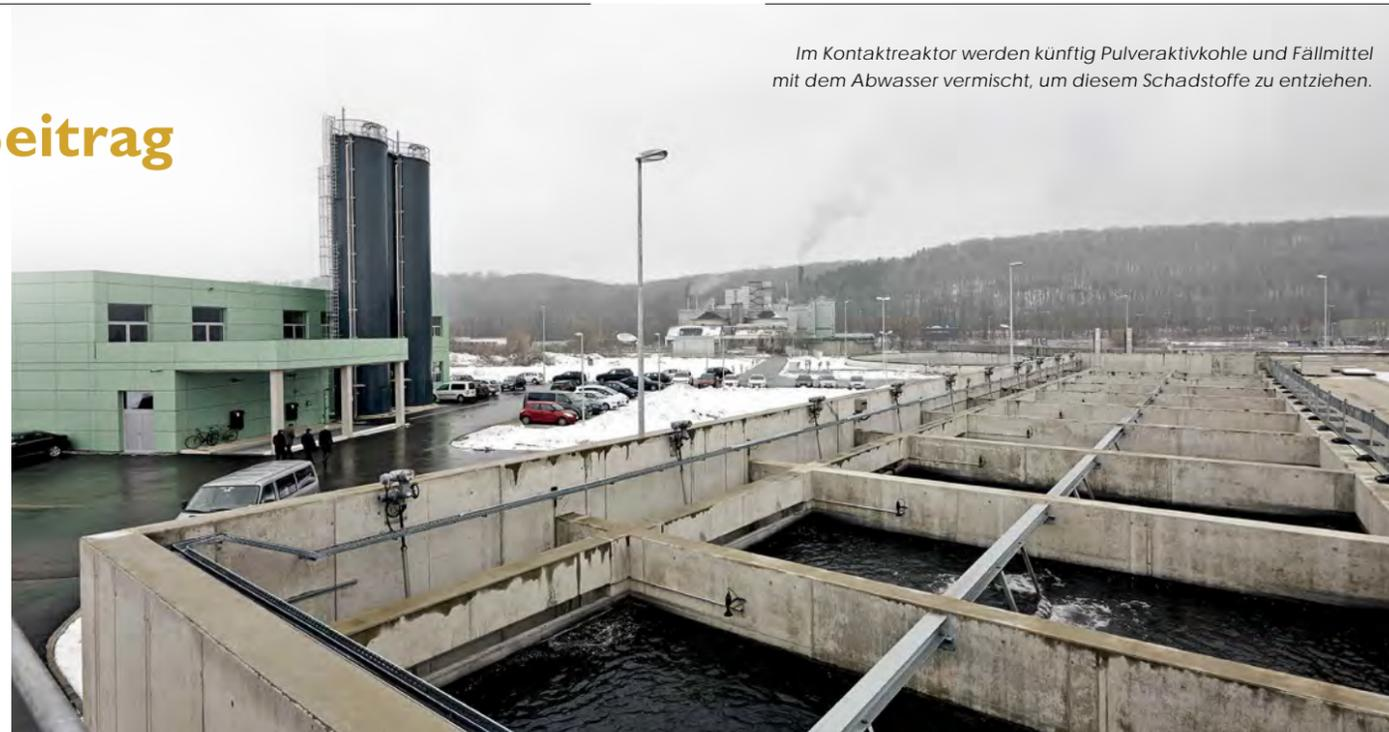
Im Kontaktreaktor werden künftig Pulveraktivkohle und Fällmittel mit dem Abwasser vermischt, um diesem Schadstoffe zu entziehen.
