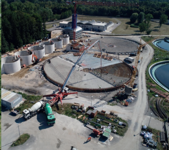
Kläranlage Karlsruhe, 4. Reinigungsstufe im Bau
