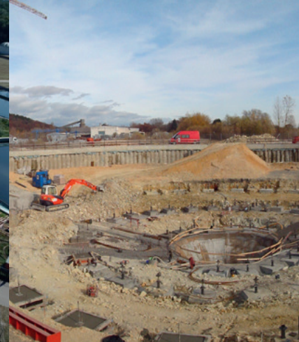
Klärwerk Steinhäule, neues Sedimentationsbecken der 4. Reinigungsstufe im Bau
