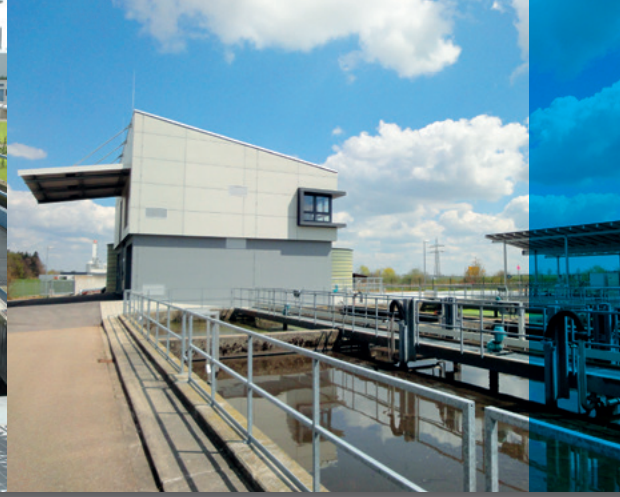
Kläranlage Laichingen mit Aktivkohle- und nachgeschaltetem Tuchfilter
