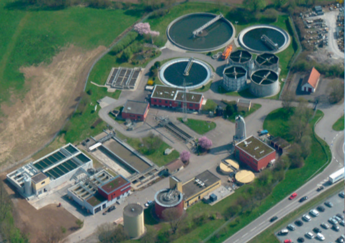
Kläranlage Öhringen mit Einsatz von Pulveraktivkohle
