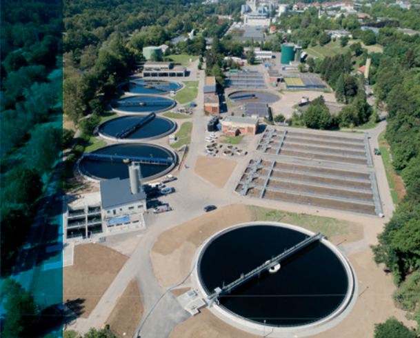
Kläranlage Pforzheim, 4. Reinigungsstufe
