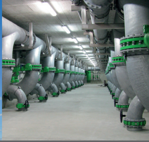
Klärwerk Breisgauer Bucht, Rohrkeller der Filtrationsanlage
