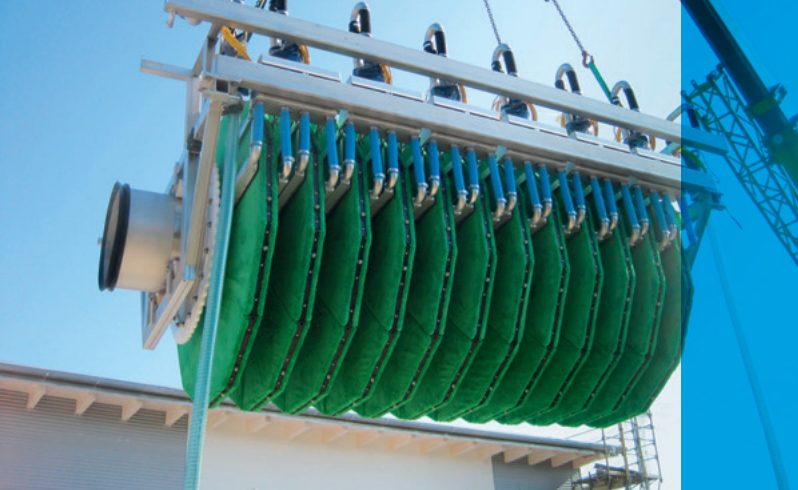
Kläranlage Lehr, Einbau des neuen Tuchfilters
