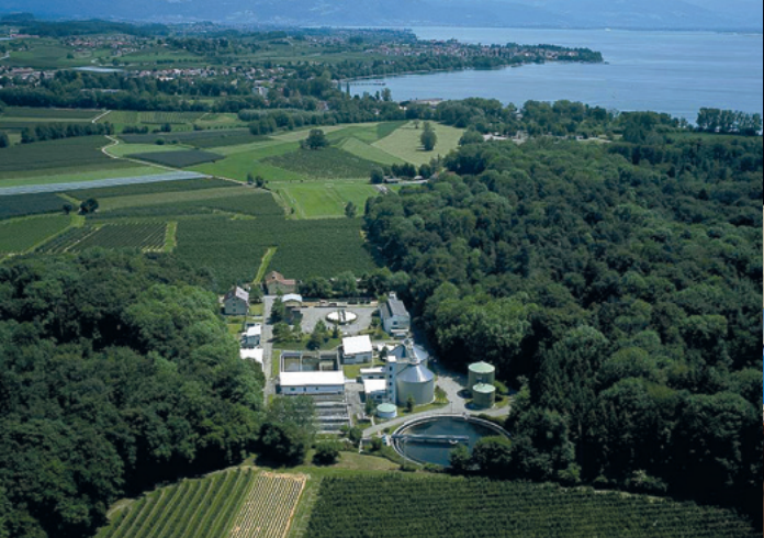
Kläranlage Kressbronn am Bodensee mit einer Reinigungsstufe zur gezielten Spurenstoffelimination
