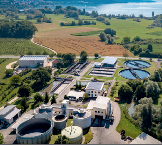
Kläranlage Stockacher Aach am Bodensee
