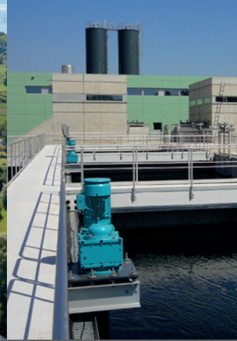
Zweckverband Klärwerk Steinhäule, Neu-Ulm
