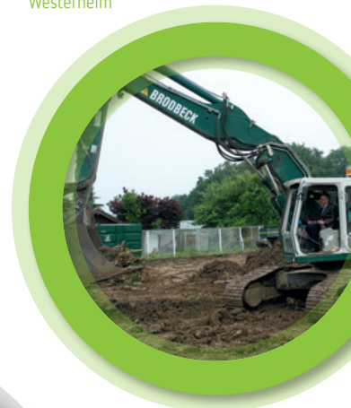
Baggerbiss für das neue Filtergebäude auf der Kläranlage Westerheim
