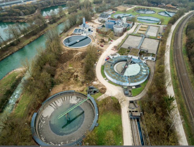
Kläranlage Wendlingen am Neckar nach Fertigstellung der Reinigungsstufe mit Pulveraktivkohle
