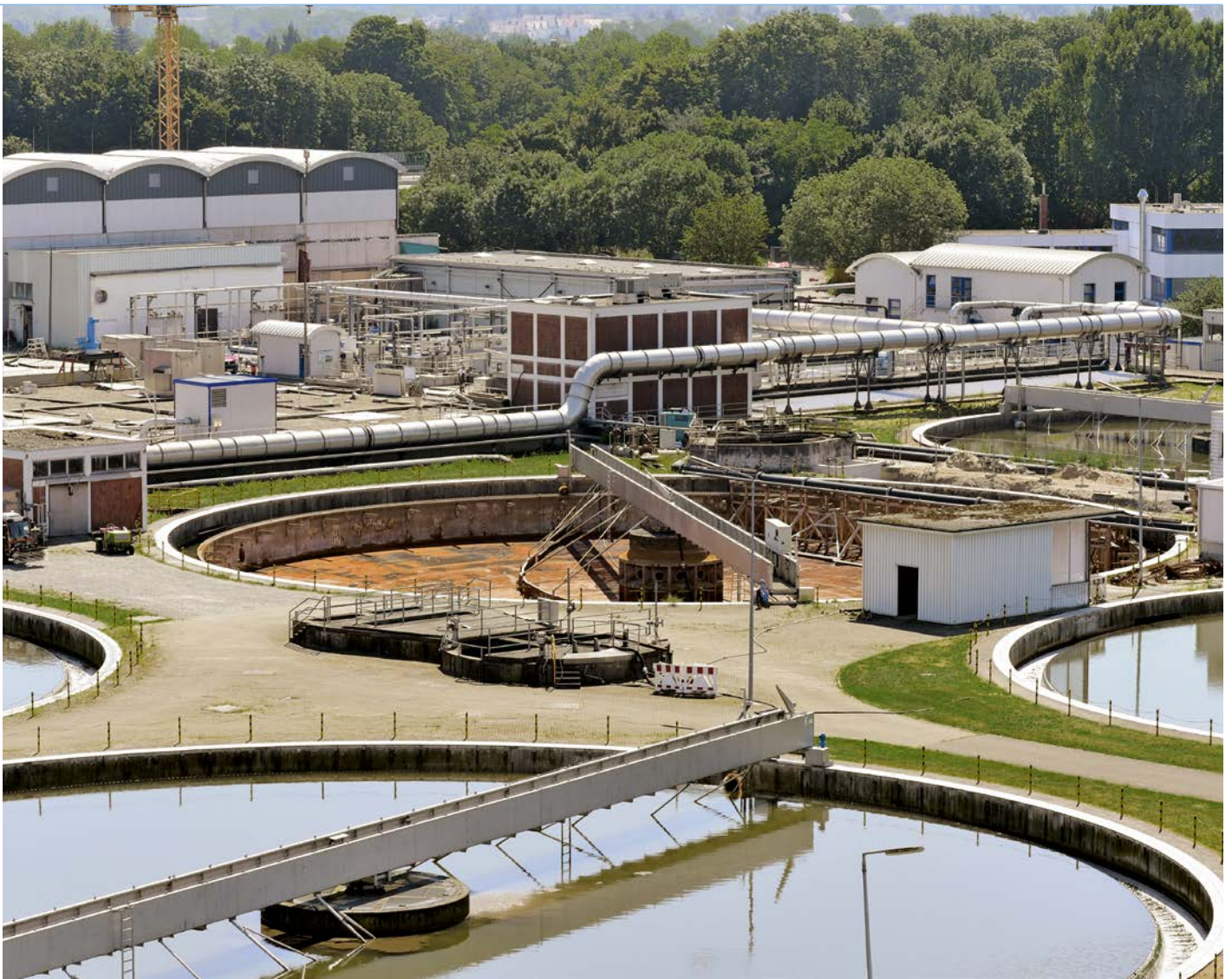
Kläranlage Karlsruhe-Neureut: Nachklärbecken
