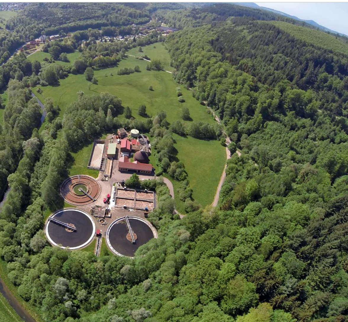
Albtal, im Vordergrund Kläranlage
