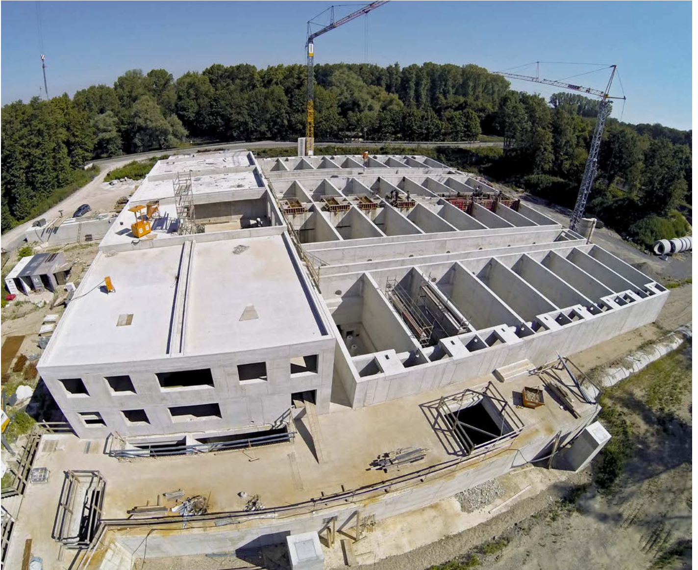
Kläranlage Karlsruhe-Neureut - Filtrationsanlage und Aktivkohlestufe im Bau
