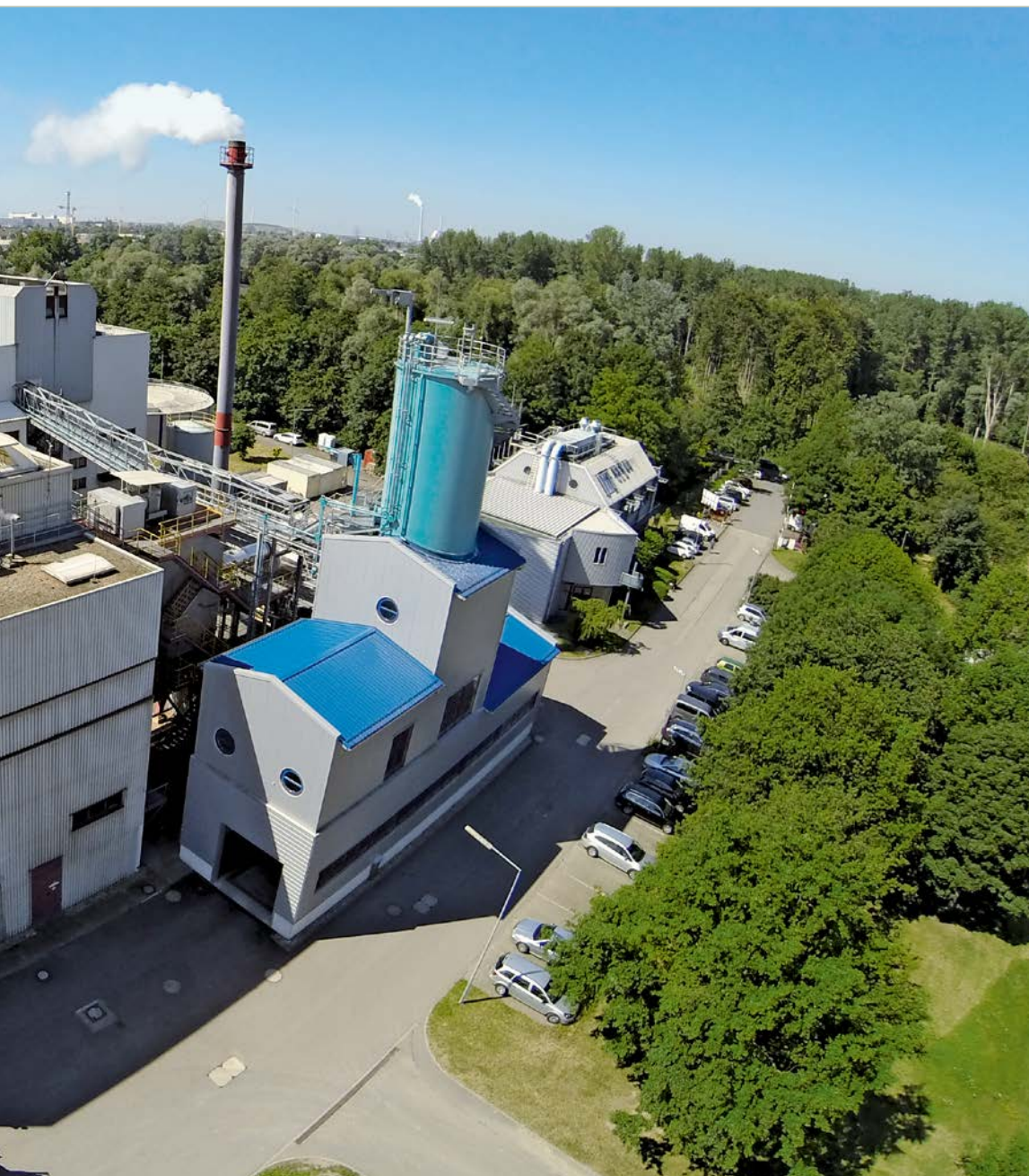
Kläranlage Karlsruhe-Neureut, Klärschlammverbrennung
