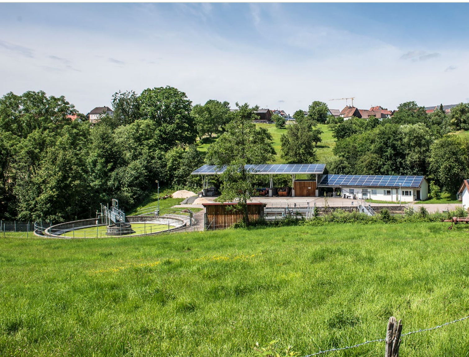
Kläranlage in Spraitbach
