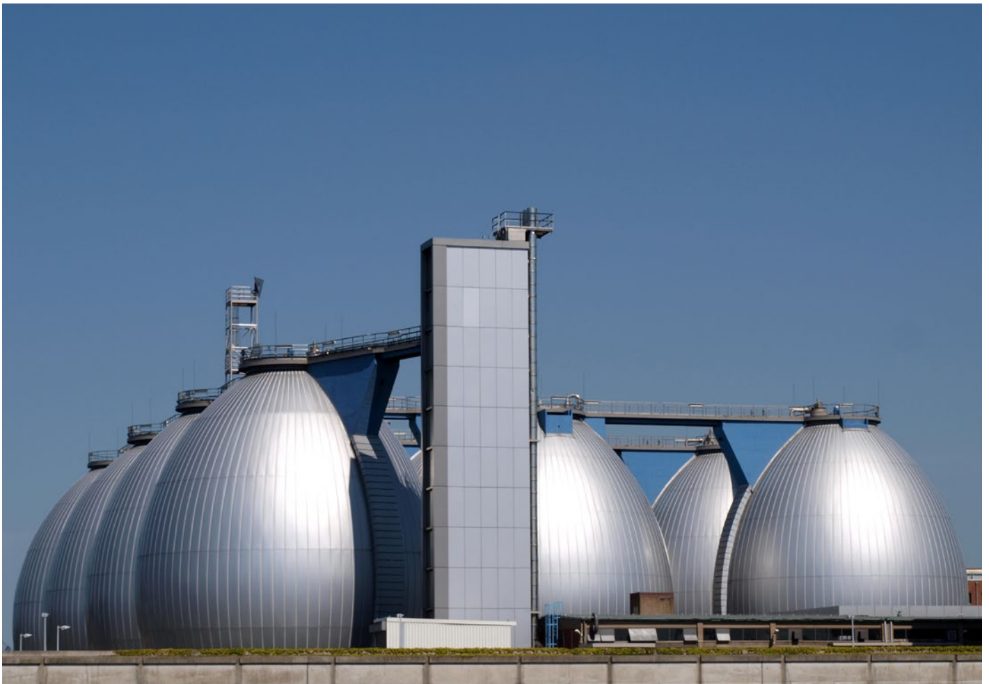
Faultürme einer Kläranlage
