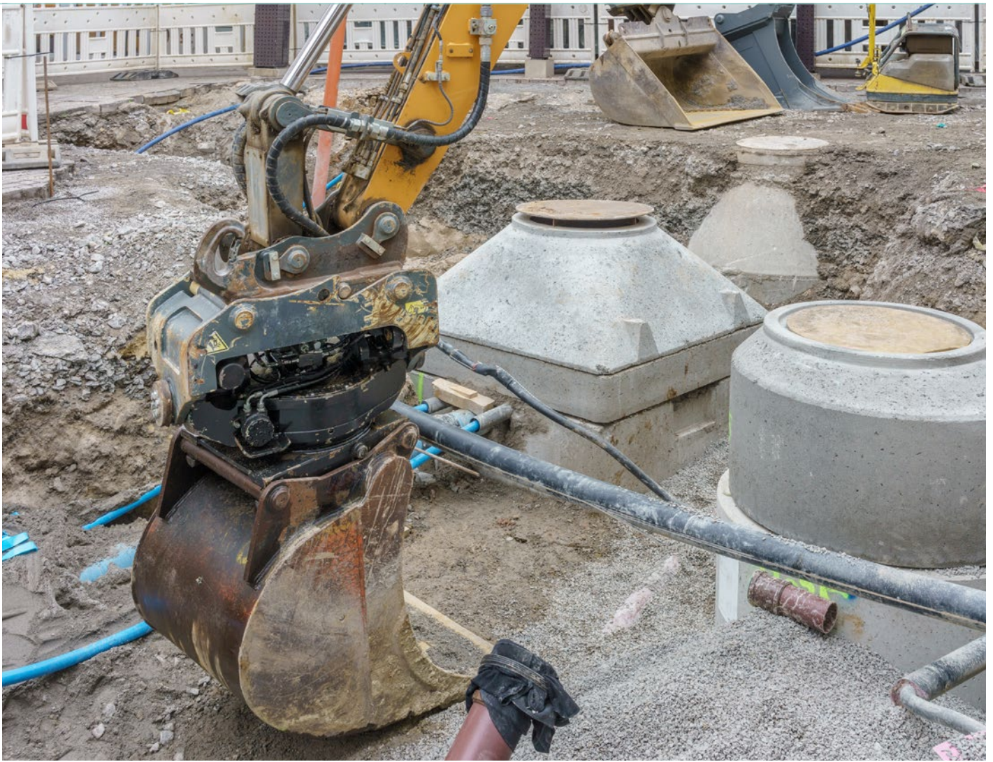
Erneuerung der Kanalisation und Wasserleitung in einer Strasse
