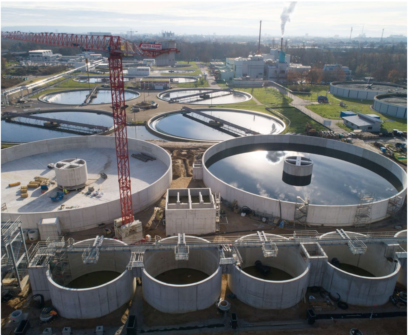
Aktivkohleadsorption der Kläranlage Karlsruhe im Bau
