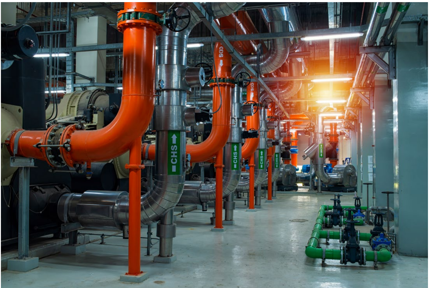
Industrieller Innenkühler und Kessel
