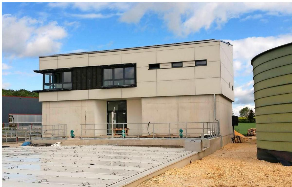
Abgedeckte Sedimentationsbecken vor dem Betriebsgebäude für die vierte Reinigungsstufe in der Kläranlage Laichingen. FOTOS: SAG-INGENIEURE
