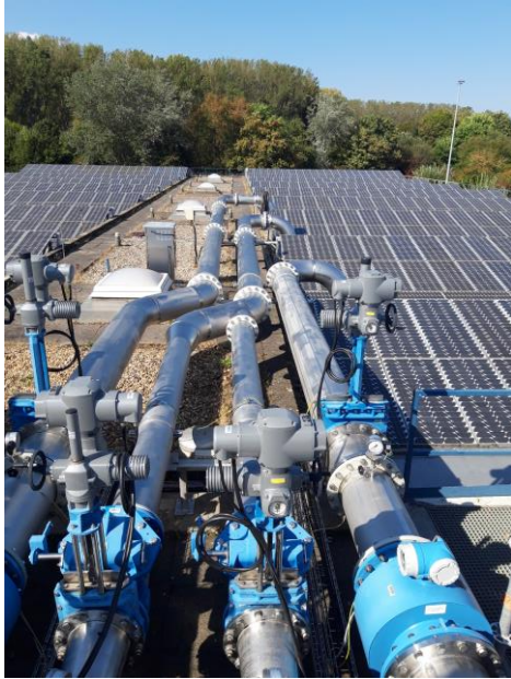
Abbildung 2: Zulaufverrohrung (links), Filter in Betrieb (rechts) (Quelle: KomS)
