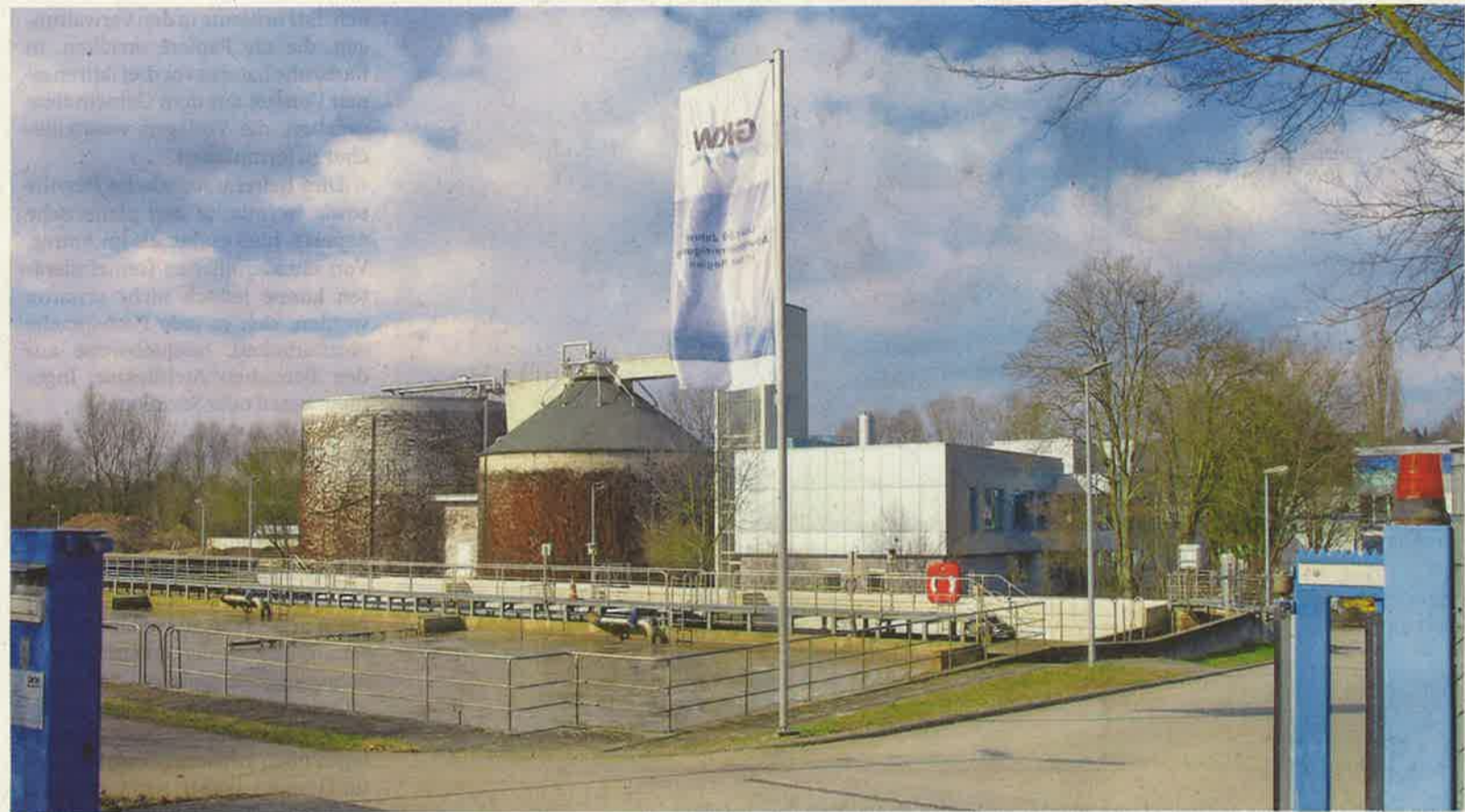
In der Kläranlage in Wendlingen soll die vierte Reinigungsstufe, die auch Spurenstoffe entfernt, noch in diesem Jahr in Betrieb gehen. FOTO: SCHMIDT
