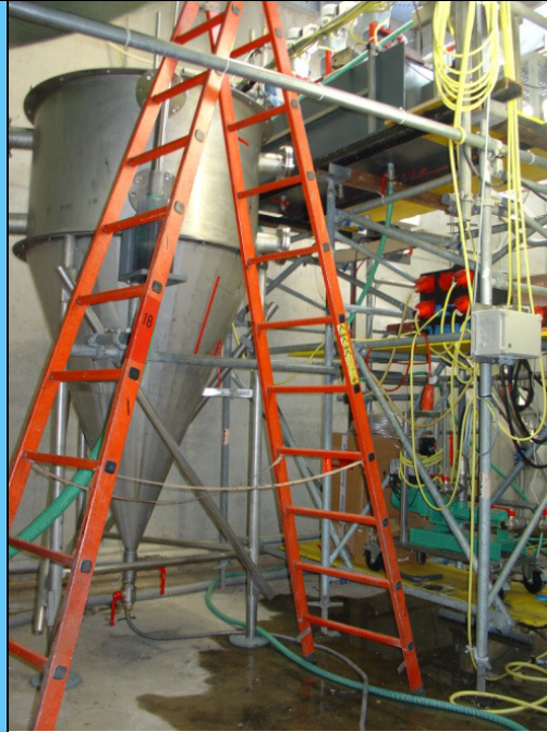
Bild 1: Versuchsanlage auf dem Gelände des Klärwerks der Stadt Karlsruhe
