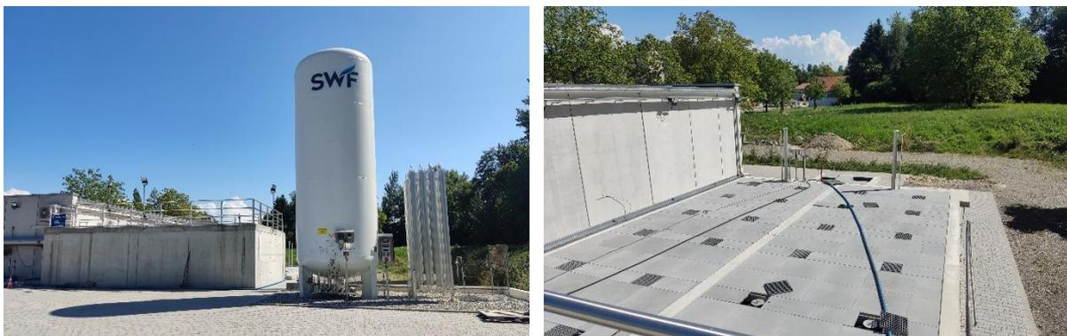
Abbildung 1: Ozonreaktor (links) und GAK-Filter (rechts), Fotos: KomS
