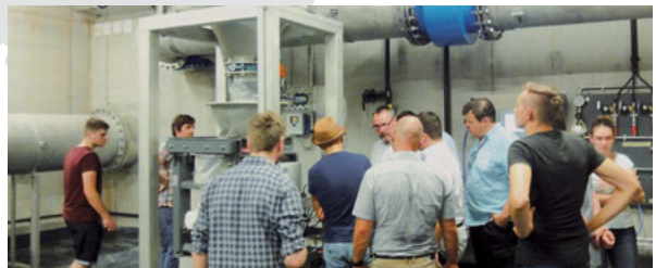
Besichtigung der Kläranlage Lahr von den Teilnehmern der Sonder-Nachbarschaft Spurenstoffe
