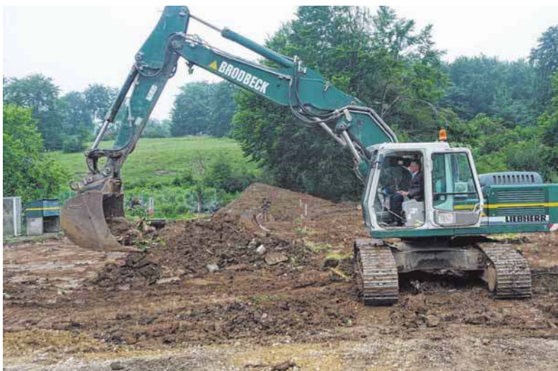
Den Baggerbiss für die Erweiterung der Kläranlage nahm Westerheims Bürgermeister Hartmut Walz nach dem offiziellen Spatenstich vor. FOTO: PR
