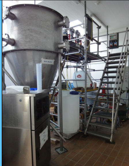
Bild 1: Versuchsanlage auf dem Gelände des Klärwerks Lahr
